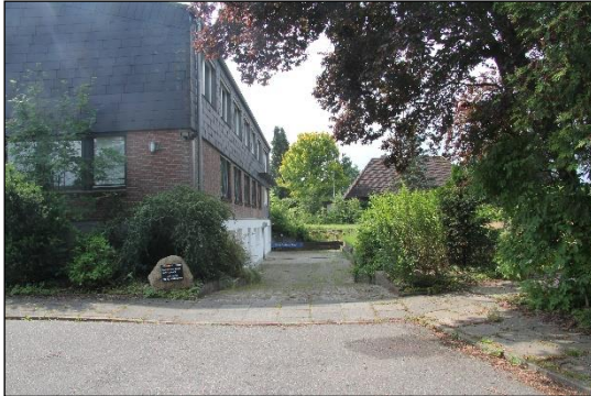
Blick auf das Bürogebäude Ansicht von Norden
