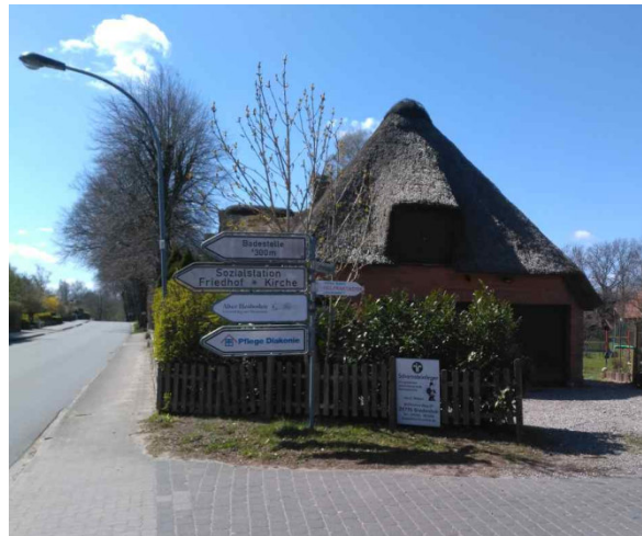
Foto: Giebelseite des Gebäudes Dorfstraße 72
