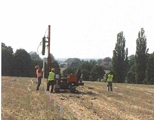
Abbildung 3: Beispieldarstellung Rammung
