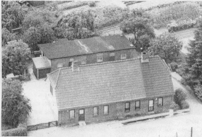
Das Doppelhaus vor der Restaurierung
